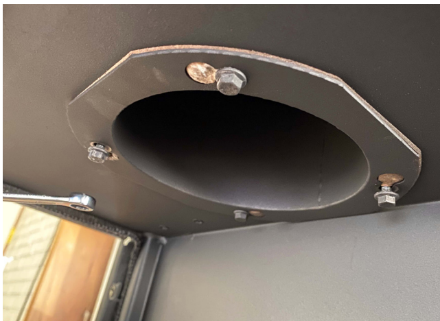
1. Draai twee van de bouten diagonaal los.
